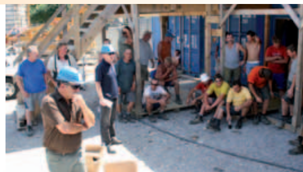
In Salzburg wurde die UV-Schutzaktion u. a. auf der Baustelle der ARGE Unipark durchgeführt.
